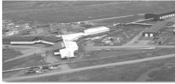
Рис. 4. Административно-жилой комплекс «Северный клевер» с медицинским пунктом на о. Котельный
